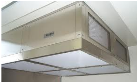
Filtres terminaux (flux ou plafonnier)
